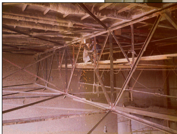
Cementárňa B. Bystrica
