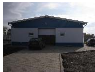
čelný pohľad po dokončení stavby
