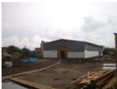
hrubá stavba a zateplovanie
