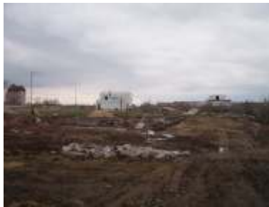
úplný začiatok výstavby
