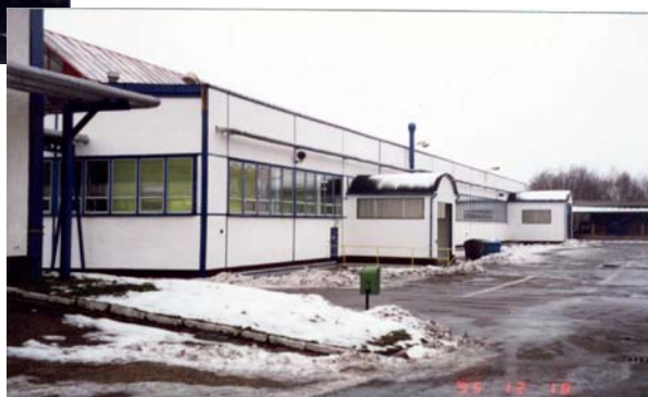
Výmena STAKO okien, fasáda
