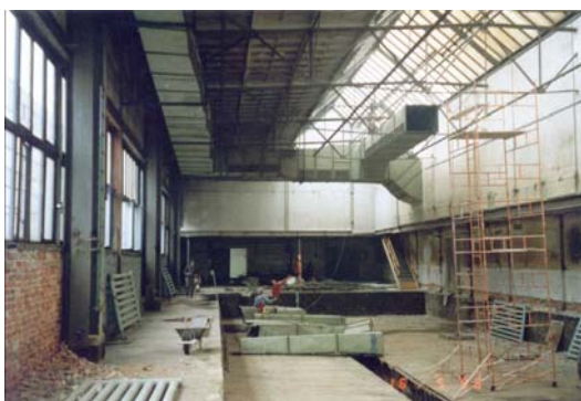
Rekonštrukcia výrobnjej haly, výstavba kancelárií
